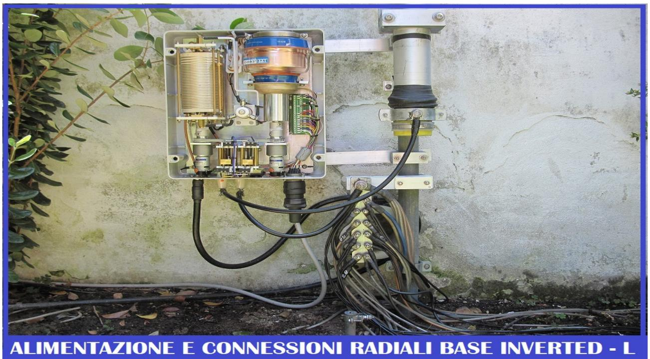
Come è possibile osservare dalla fotografia l'antenna Inverted-L deve essere corredata da una numerosa serie di radiali di lunghezza non calcolata disposti possibilmente a raggiera. Da Pierangelo i2noi che aveva spazio, sono stati predisposti ai piedi dell'antenna anche una ventina di metri quadrati di "Chicken Wirer" (rete da pollaio). Questo perché il piano di terra è molto importante in particolare con questa tipologia d'antenna per avere bassi angoli di radiazione, pre-
