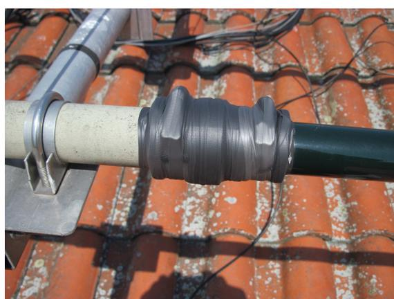
Sempre per lo stesso motivo, consiglio di bloccare i vari cavi dei motori sulla parte inferiore del boom in modo che non siano direttamente esposti al sole e alle intemperie. La soluzione ottimale ritengo invece sarebbe stata prevedere
