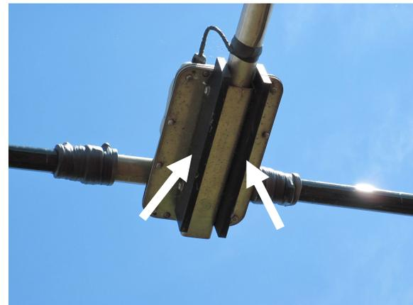
**4)** Ho sostituito il sistema d'ancoraggio dei tiranti in Phillystran, previsto in origine tramite una staffa direttamente fissata al mast, ad una altezza di circa 80 cm sopra il boom. La soluzione adottata in origine dalla casa produttrice, sin dalla prima installazione e nelle successive manutenzioni, causava un
