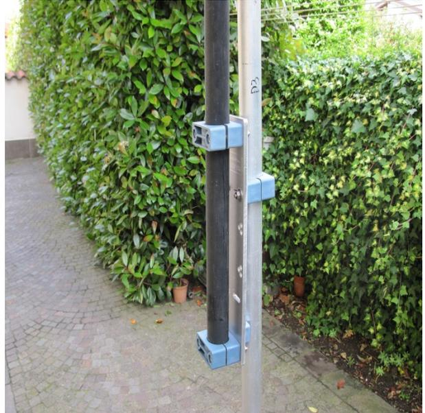
In alternativa con un po' di manualità si potrebbe facilmente auto-costruire sempre impiegando collari Pi.Effe.Ci., piastra di alluminio da 8-10 mm di spessore e collari Fischer. (vedi es. foto)
