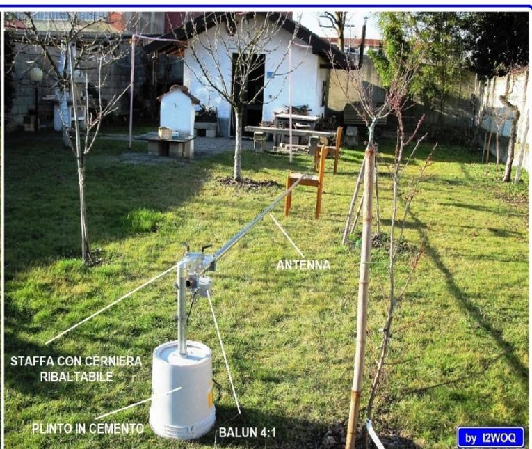
**VISTA DI ALCUNI PARTICOLARI COSTRUTTIVI IN FASE DI MONTAGGIO E MESSA A PUNTO**
