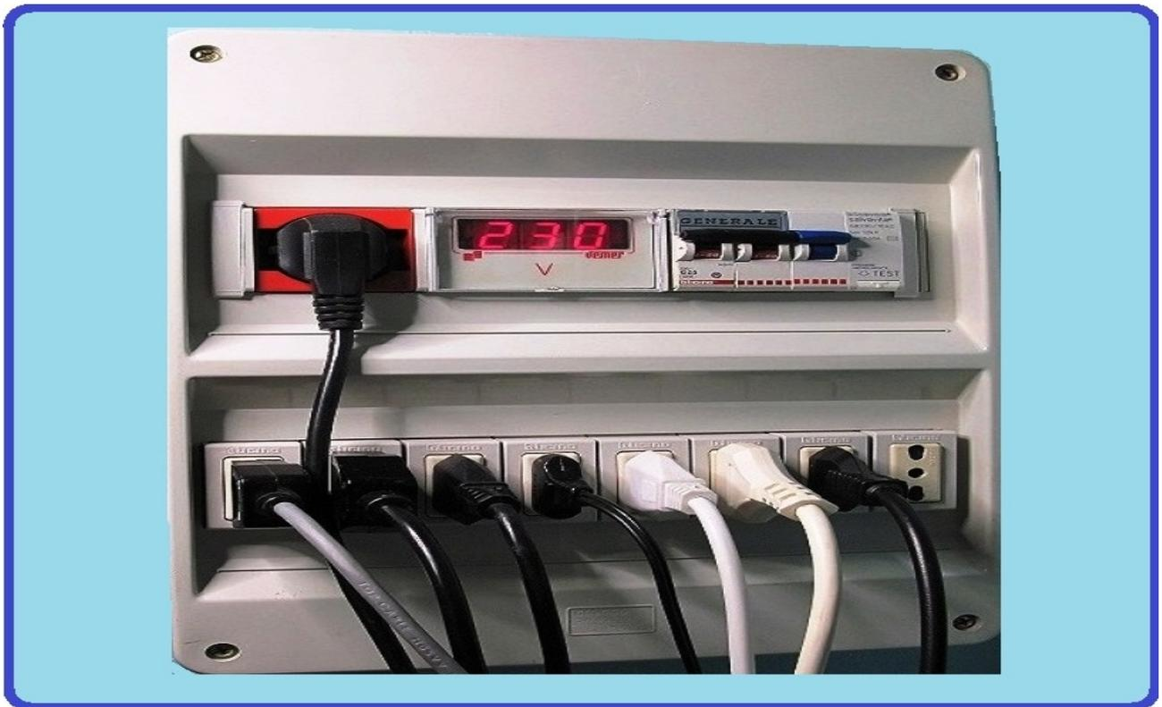
La soluzione ottimale per cercare debellare quanto appena descritto, resta quella di utilizzare cassette di derivazione fissate a muro con un numero di prese sufficienti a soddisfare tutte le esigenze. All' interno del contenitore realizzare il relativo circuito elettrico sulla falsariga dello schema proposto dalla prossima immagine.
